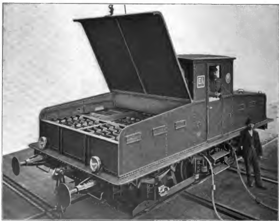
Fig. 184. Akkumulatorenlokomotive während der Ladung. Akkumulatorenraum geöffnet.
